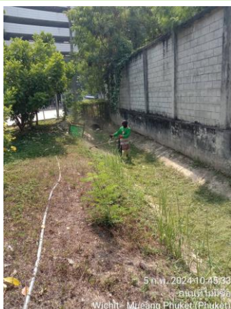
รูปที่ 3-26 ขุดลอกตะกอนในรางระบายน้ำ
