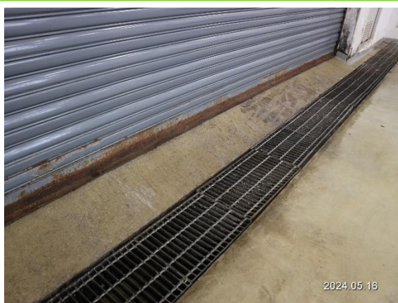
รูปที่ 3-27 ตะแกรงดักมูลฝอย
