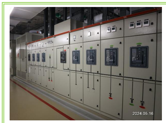
รูปที่ 2.5-9 Circuit Breaker
