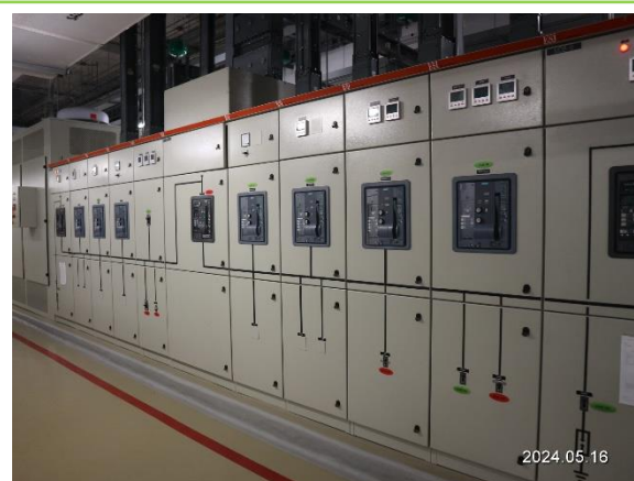
รูปที่ 3-43 Circuit Breaker
